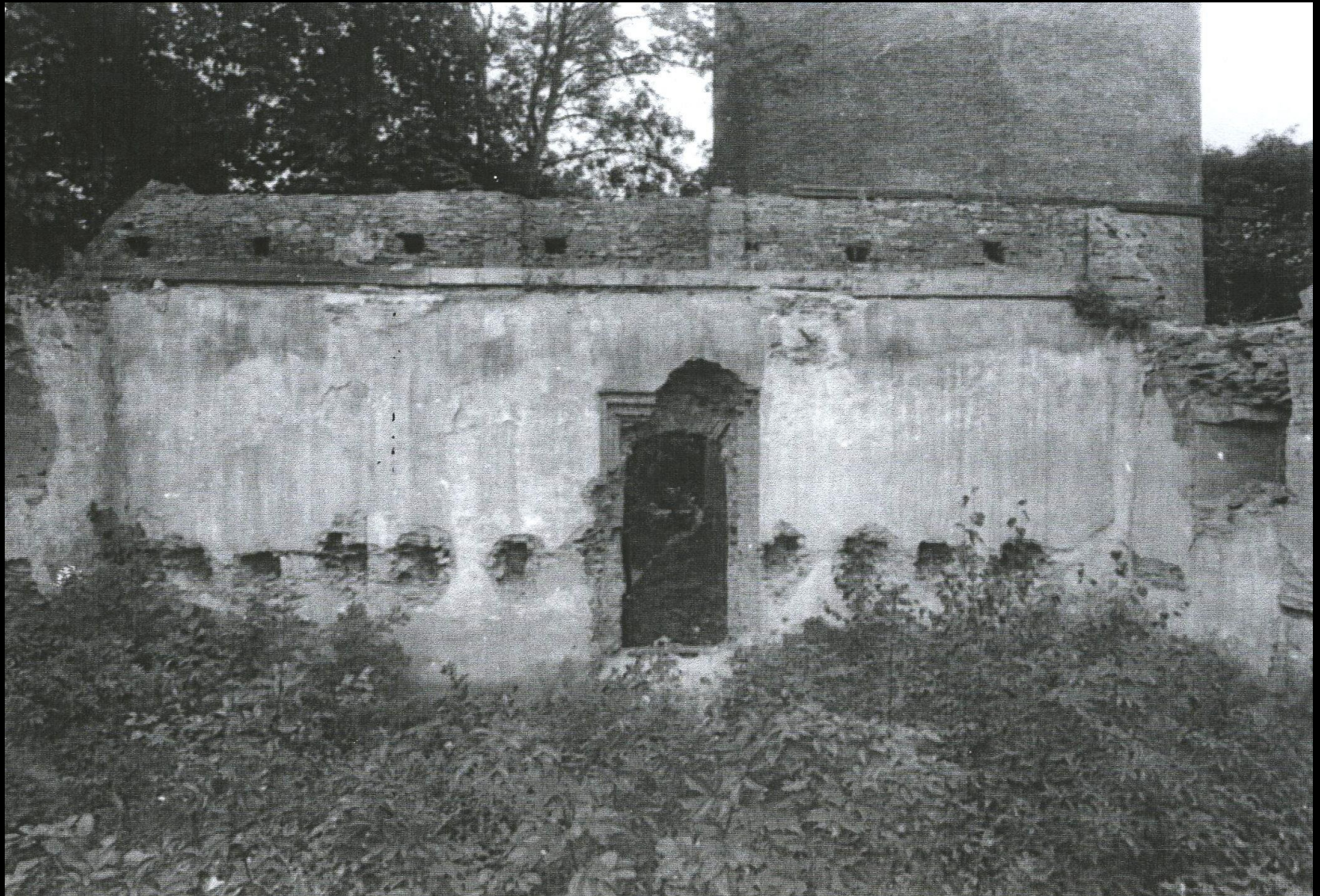
rubová strana západní obvodové zdi se zbytkem portálu vstupu na mostek ke Hlásce
