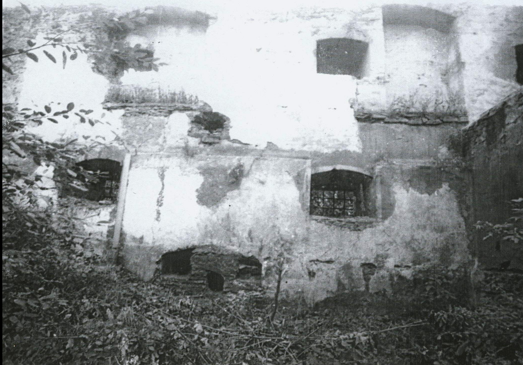
rubová strana jižní průčelní zdi
