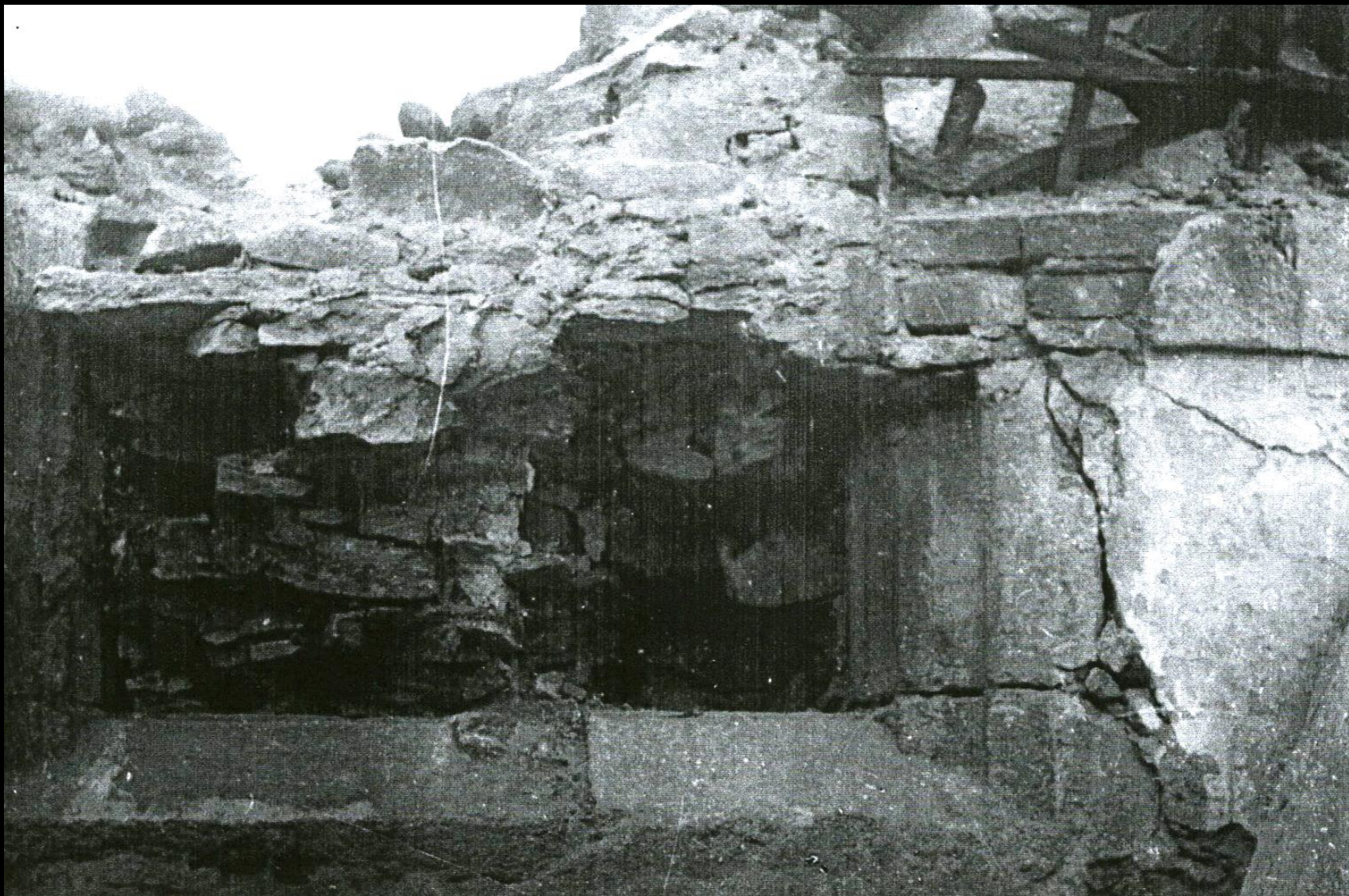
odkrytý parapet gotického křížového okna v jižním průčelí
