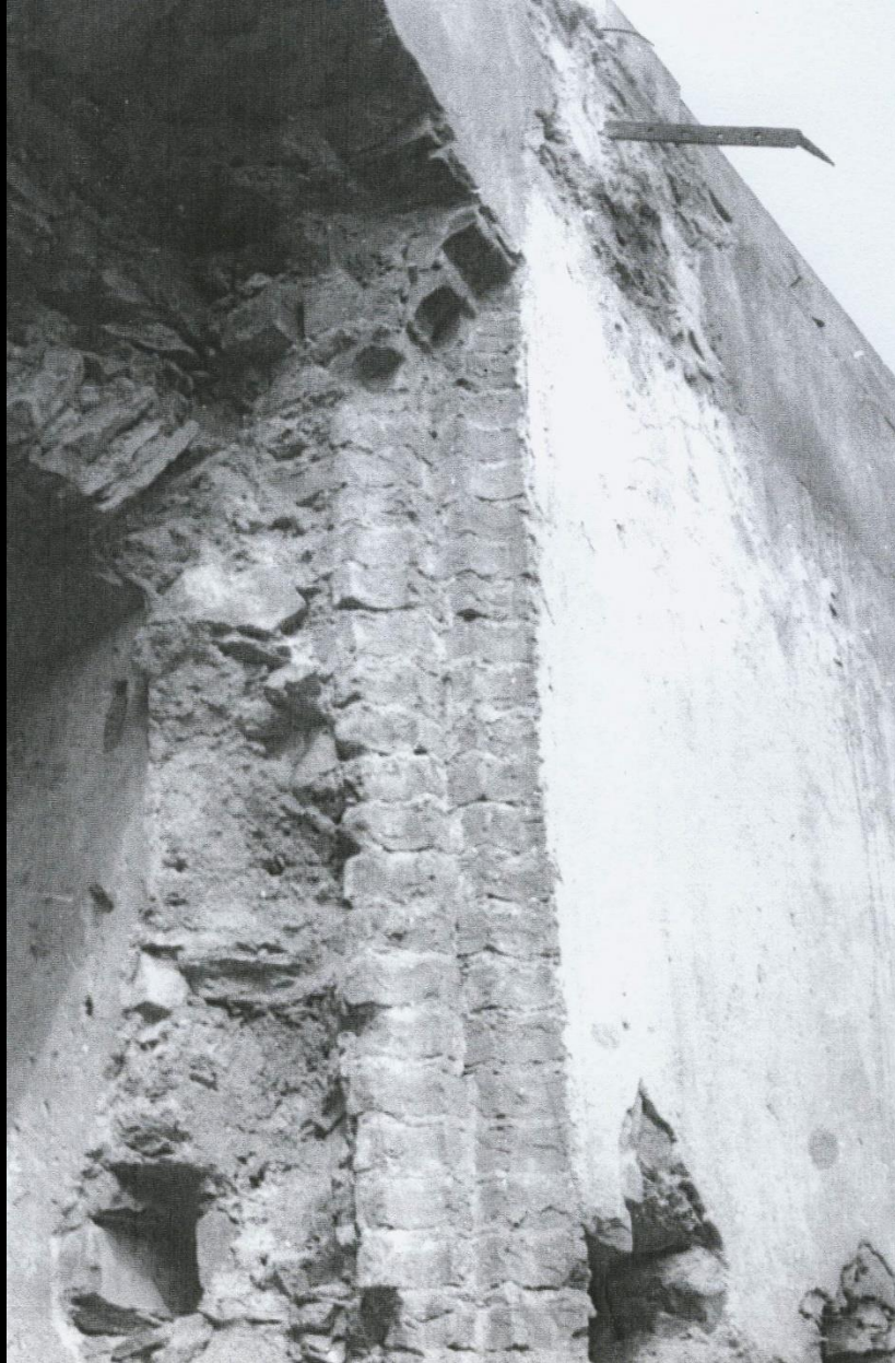
detail části okenního rámu – cihelné tvarovky, lůžko po vylomeném kamenném ostění
