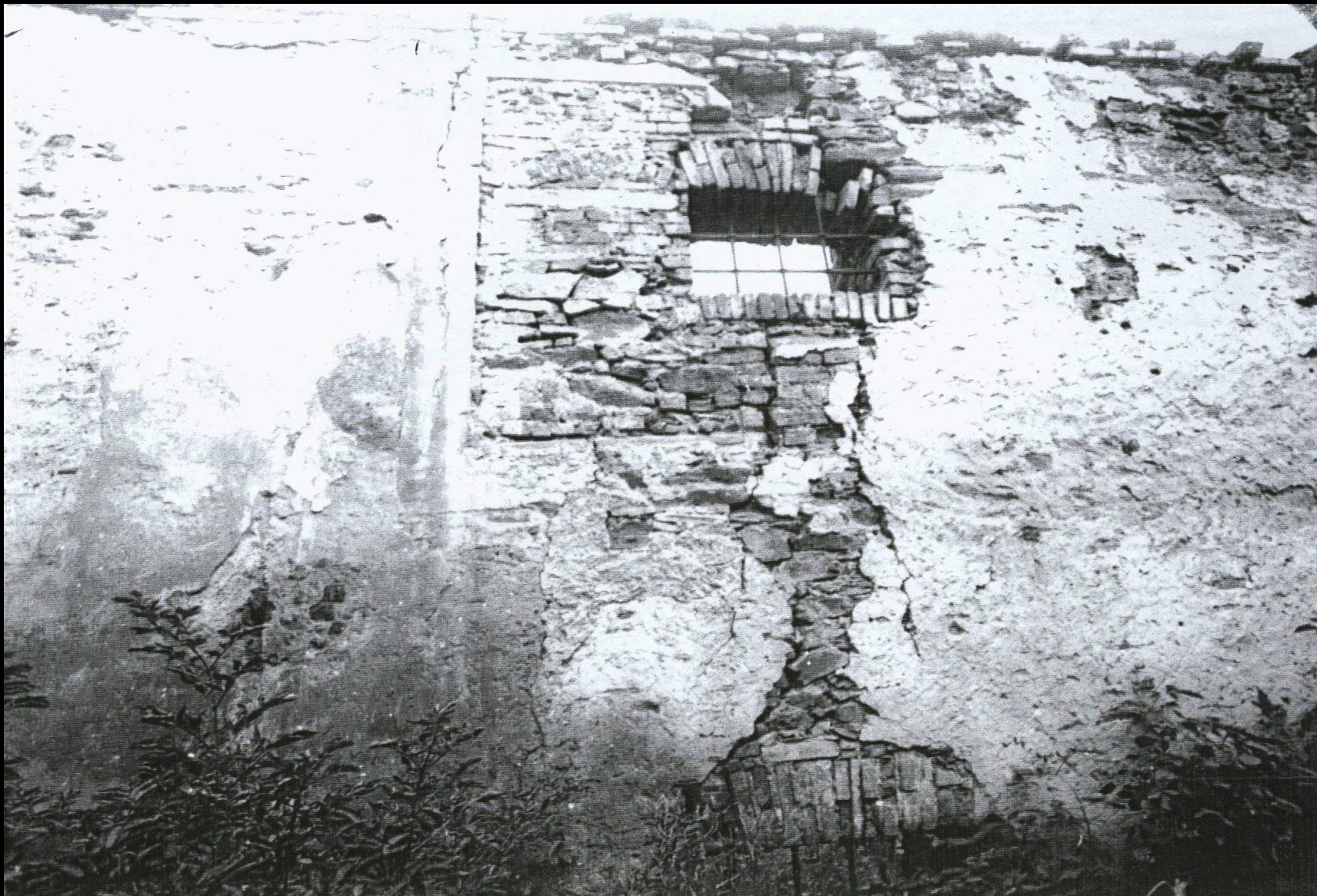
gotické okno v jižním průčelí s menším oknem z počátku 18. století
