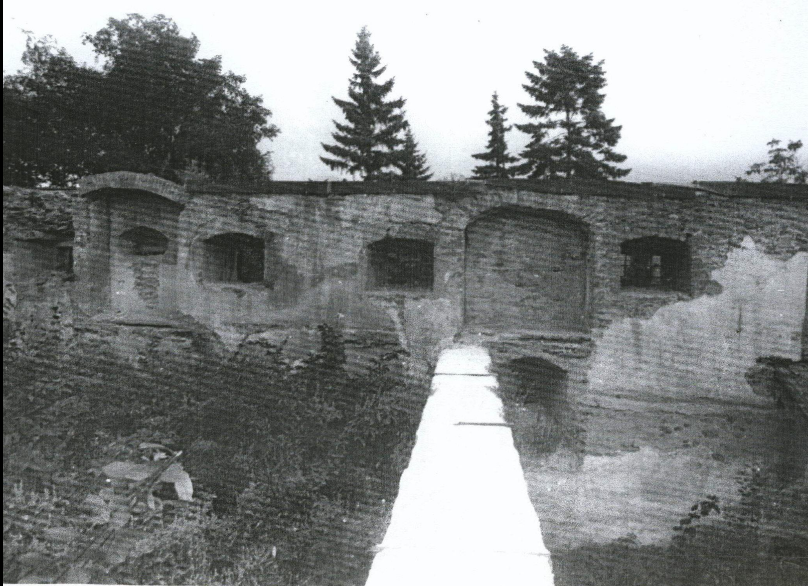
střední a západní část rubové strany severního průčelí – niky dvou původních gotických oken
