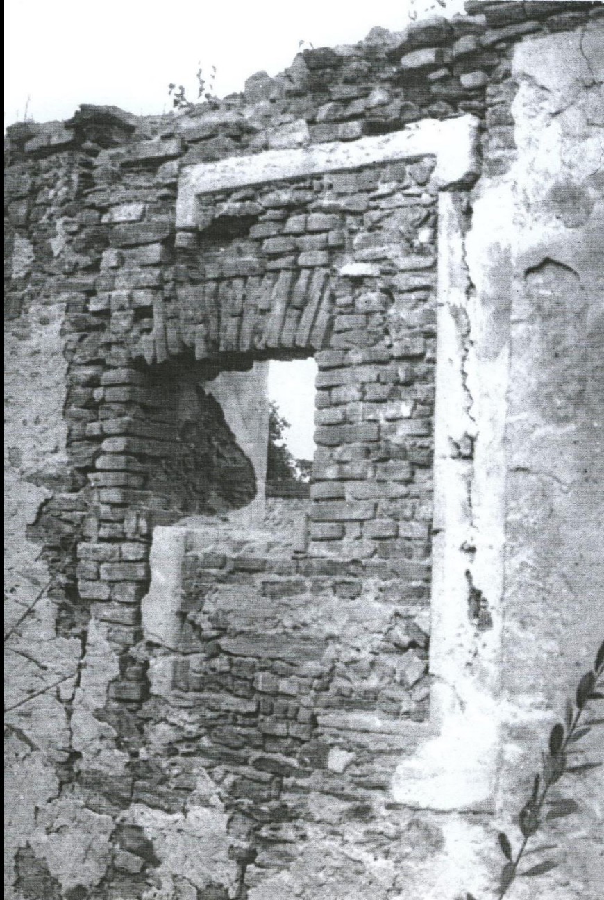
detail gotického okna s původní štukovou paspartou
